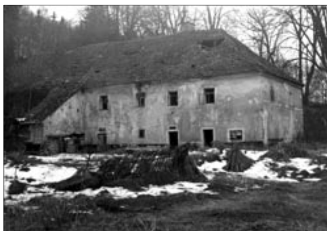
Pohled ze dvora na chátrající mlýn v roce 1985
