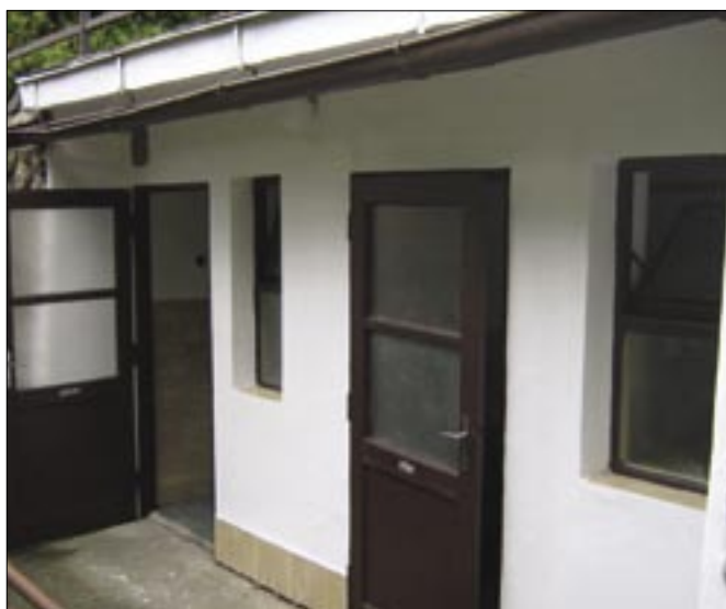
Opravené a vybielené veřejné toalety.
