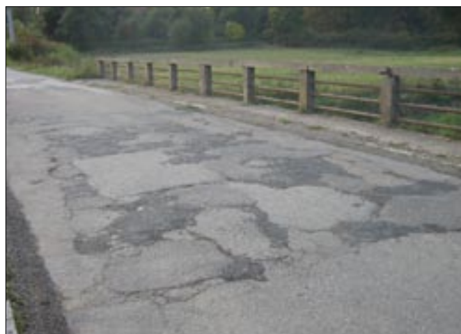
Opravené výtluky na mostě k Libouni.
