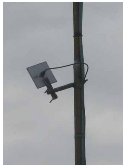
špatně uchycená anténa
